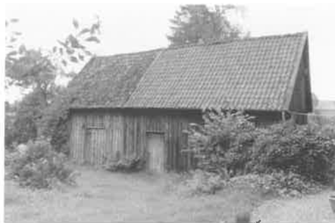
Scheune Joh. Vasbender, Freckhausener Straße 16
